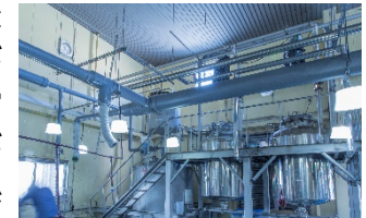
化成品製造プラント
